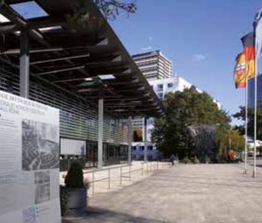
Plenarsaal mit UN Campus
